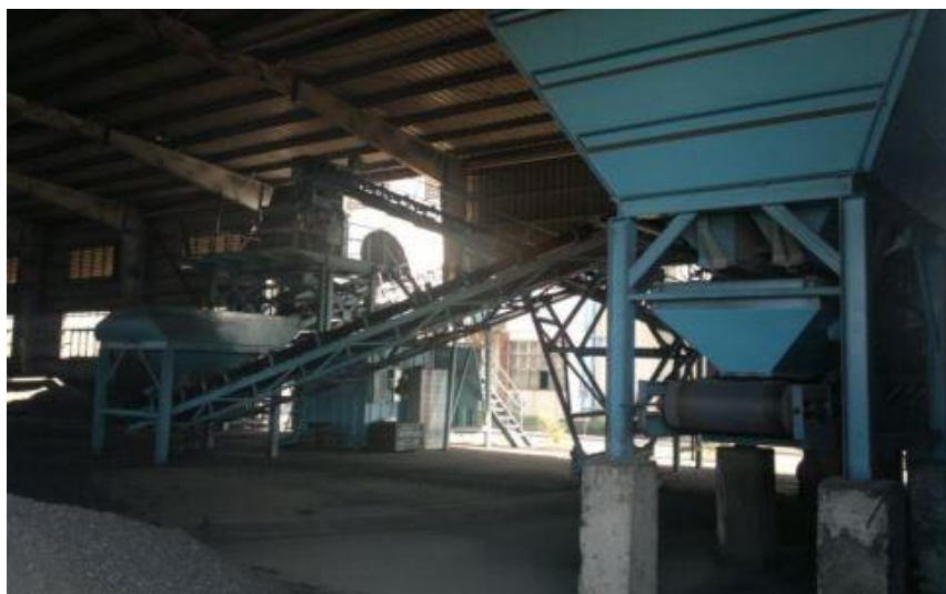
Construção e produção de fundição de escória de titânio SQC com equipamento de alimentação
