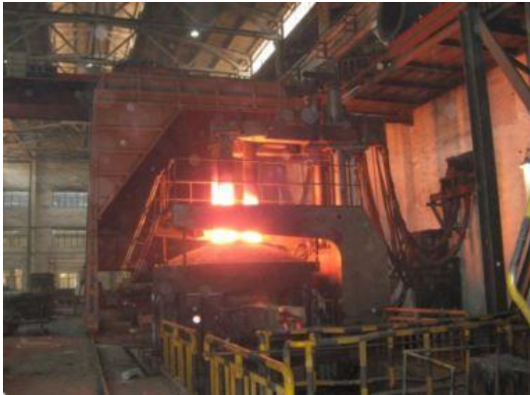
Capa de poeira de forno elétrico a arco
