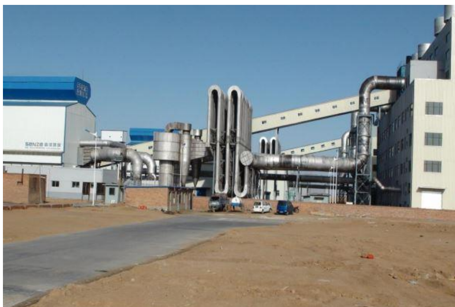
Na Mongólia, em 2009, concluiu um equipamento de forno de ferrocromo de alto carbono de 16500 kva
