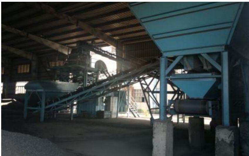
Construcción y puesta en producción de la fundición de escorias de titanio SQC con equipo de alimentación
