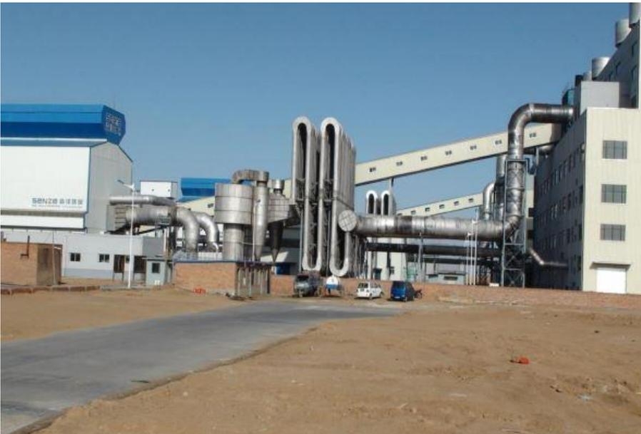
En Mongolie, en 2009, nous avons achevé un équipement de four en ferrochrome à haute teneur en carbone de 16500 kva
